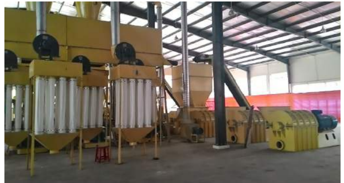
THI CÔNG LẮP ĐẶT NHÀ MÁY LEFAMI Install Lefami Factory
