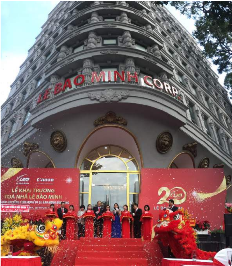
THI CÔNG NỘI THẤT TOÀ NHÀ LBM Interior design and build for LBM Building
